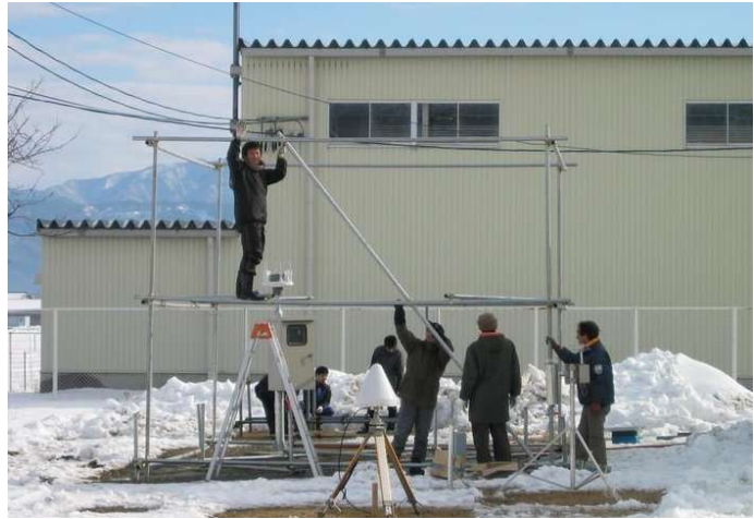
Lumiprojektissa pääsi välillä raikkaaseen ulkoilmaan pystyttämään laitteita.
